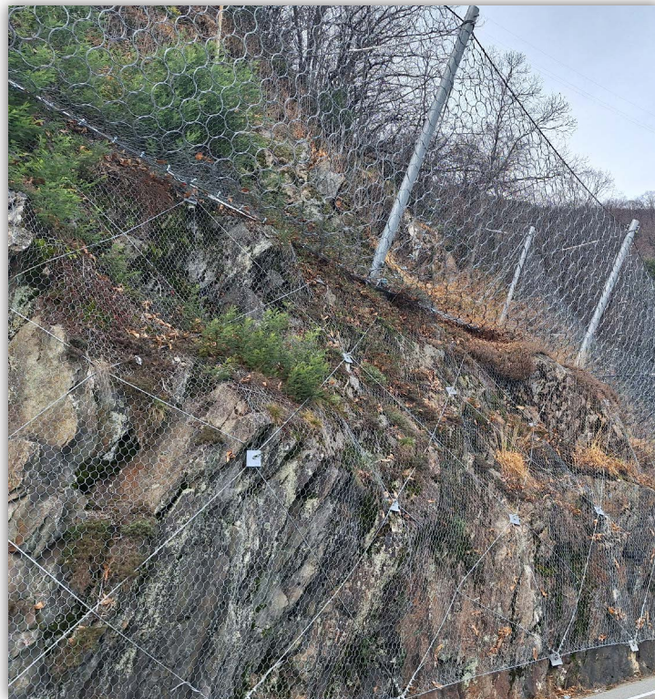
Barriere paramassi, fermaneve e simili Comune di Verbania (Provincia del Verbano-Cusio-Ossola) Lavori di monitoraggio dei comuni di Oggebbio - Cannero - Riviera - Cannobbio
