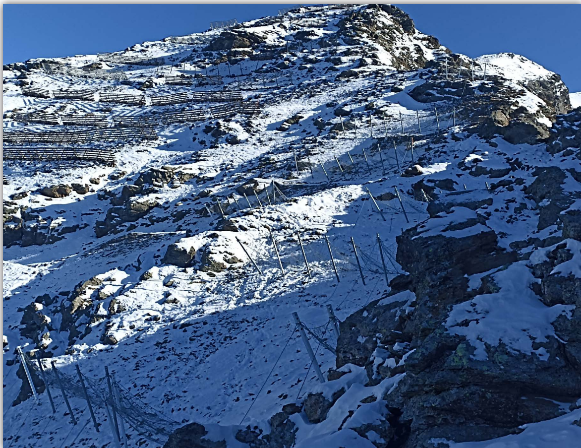
Barriere paramassi, fermaneve e simili Comune di Val di Sotto (Sondrio) Interventi di manutenzione ed integrazione delle opere di difesa attiva installate nel sito della zona di Val De Chino
