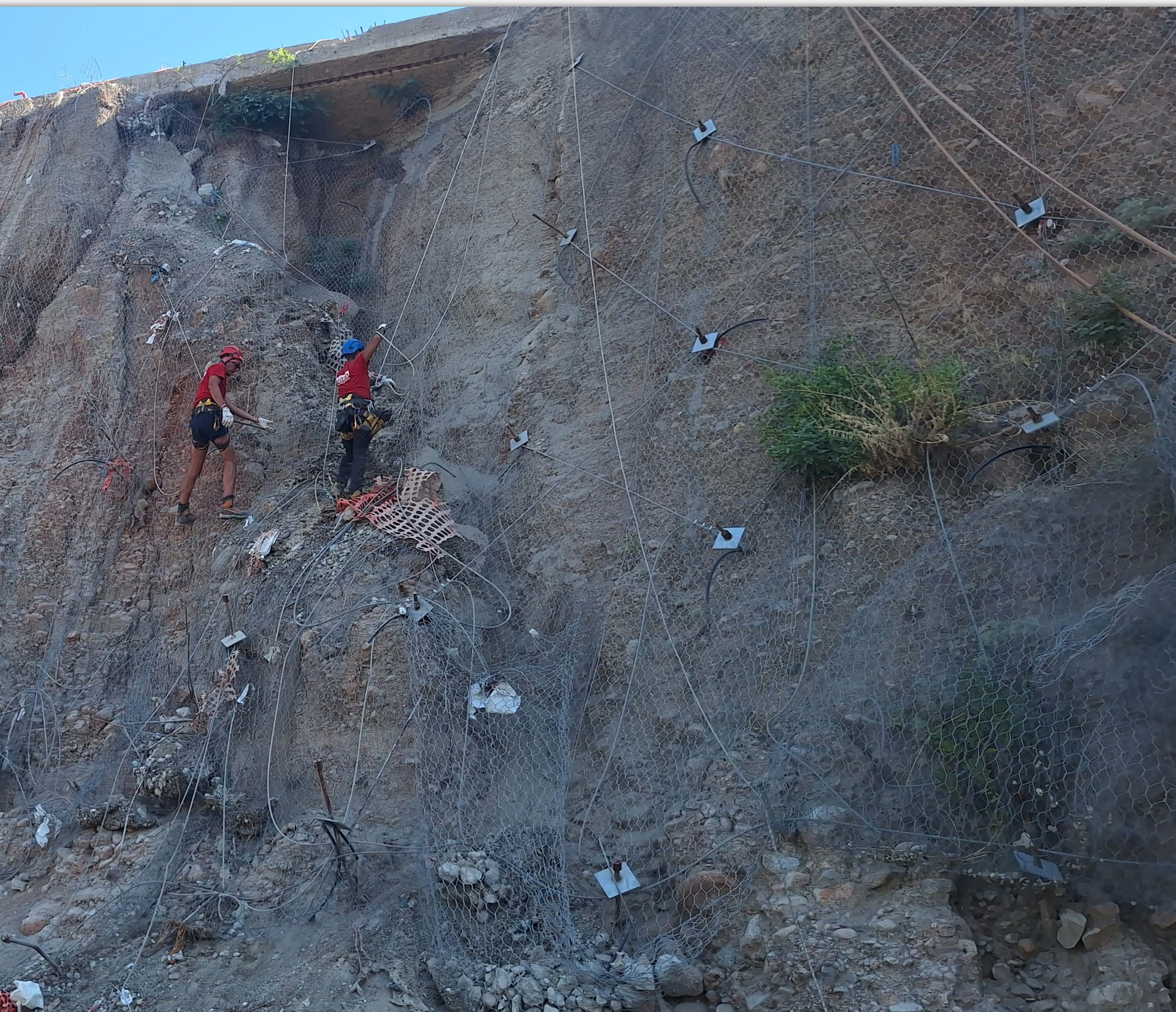
Barriere paramassi, fermaneve e simili Interventi di manutenzione ed integrazione delle opere di difesa attiva
