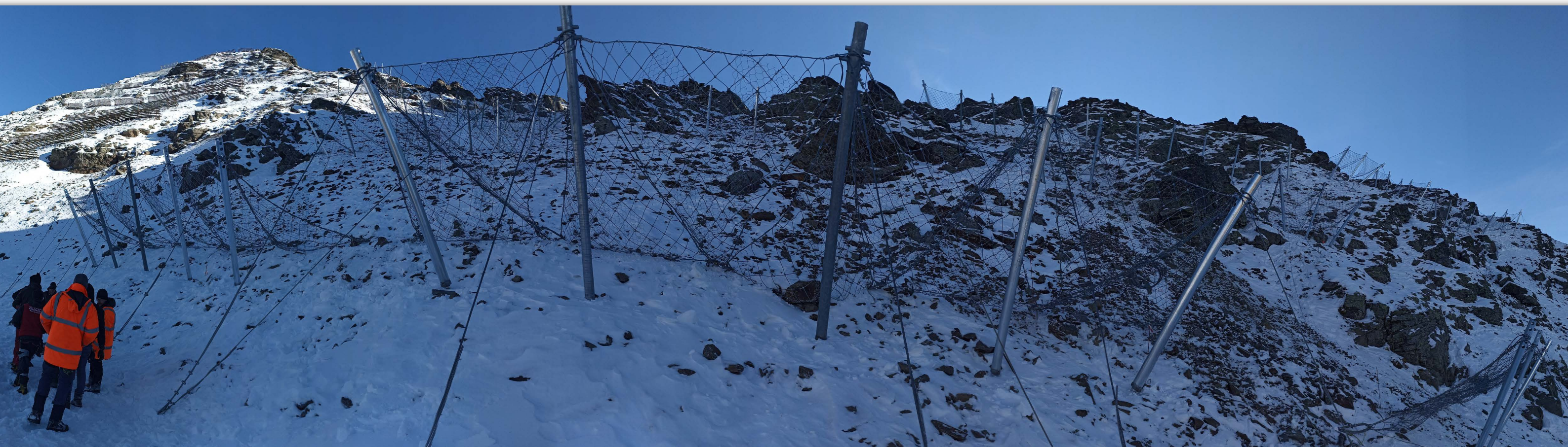
Barriere paramassi, fermaneve e simili Comune di Val di Sotto (Sondrio) Interventi di manutenzione ed integrazione delle opere di difesa attiva installate nel sito della zona di Val De Chino
