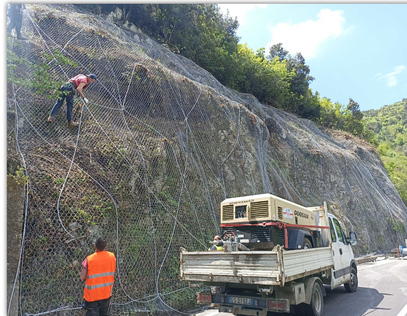
Barriere paramassi, fermaneve e simili ANAS Viabilità - SS280
