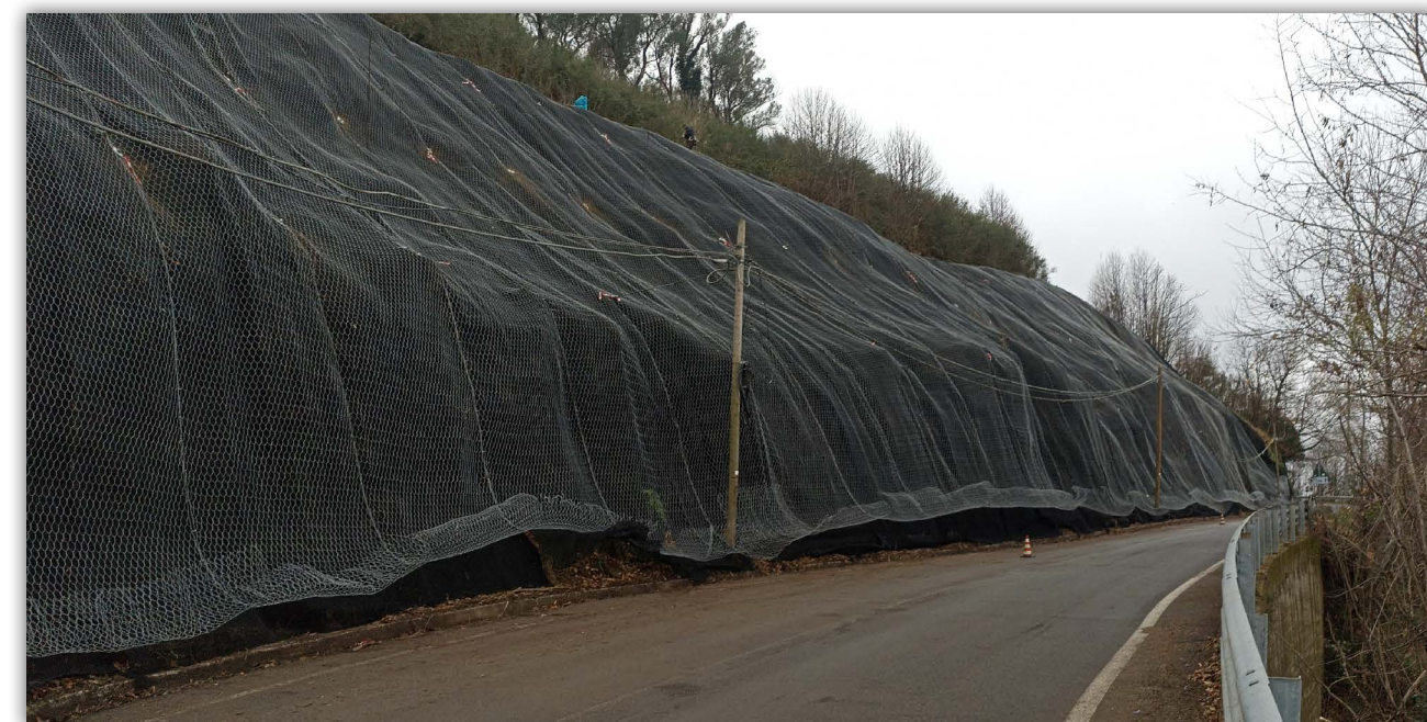
Barriere paramassi, fermaneve e simili ANAS Viabilità - SS18 Tirreno Inferiore
