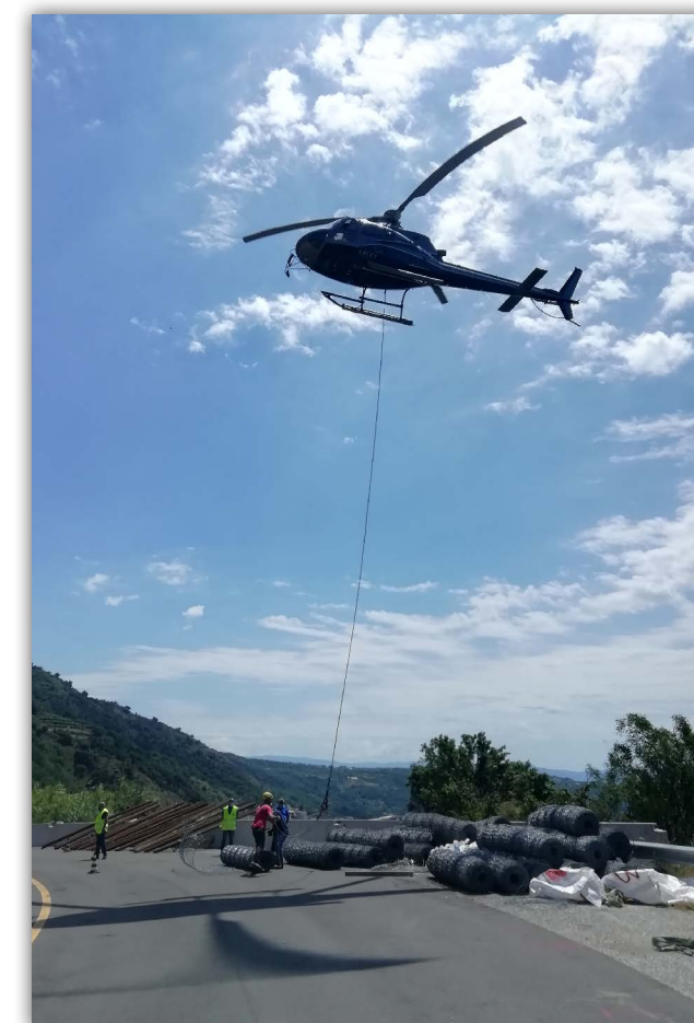
Barriere paramassi, fermaneve e simili Comune di Verbania - Consolidamento versante con difesa attiva e passiva dal km 30+680 - 30+790
