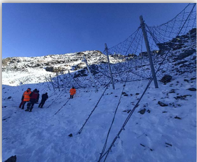
Barriere paramassi, fermaneve e simili Comune di Verbania (Provincia del Verbano-Cusio-Ossola) Lavori di monitoraggio dei comuni di Oggebbio - Cannero - Riviera - Cannobbio
