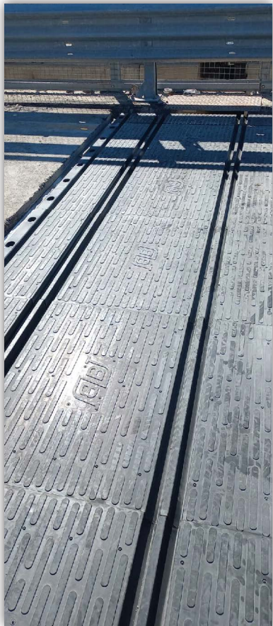
Apparecchiature strutturali speciali - Giunti stradali Amministrazione Provinciale di Catanzaro - SP 48 Viadotto Guarascio
