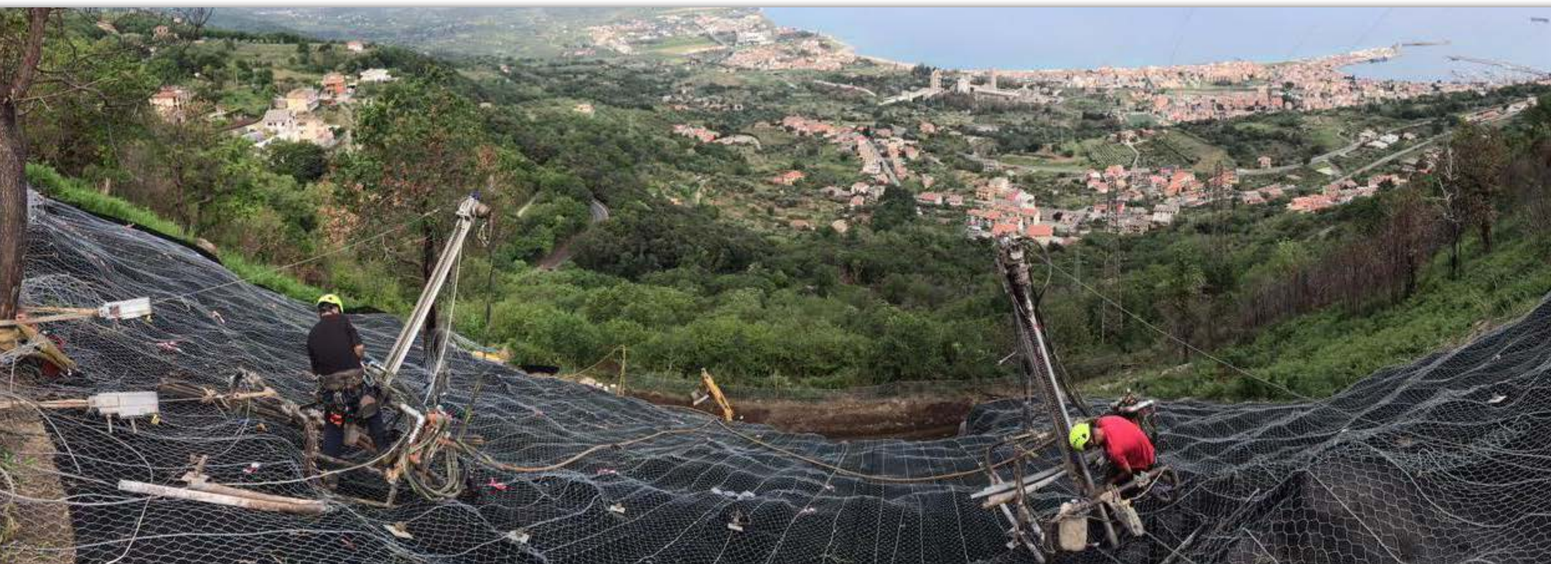
Barriere paramassi, fermaneve e simili ANAS Viabilità - SS18 Tirreno Inferiore
