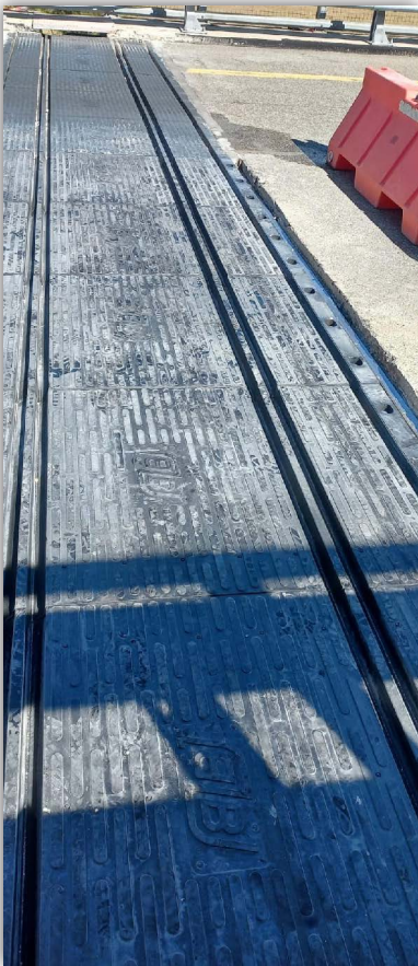
Apparecchiature strutturali speciali - Giunti stradali Amministrazione Provinciale di Catanzaro - SP 48 Viadotto Guarascio
