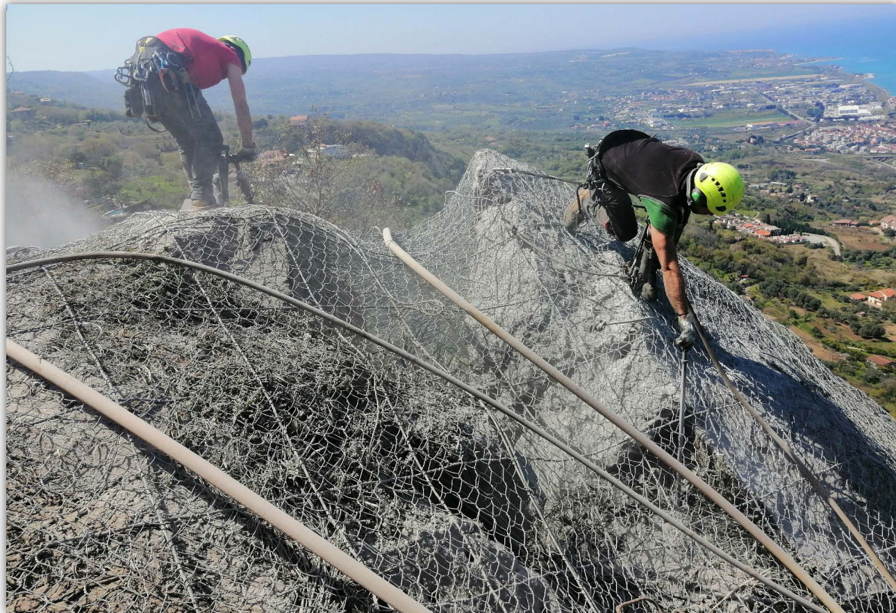
Barriere paramassi, fermaneve e simili ANAS Viabilità - SS18 Tirreno inferiore
