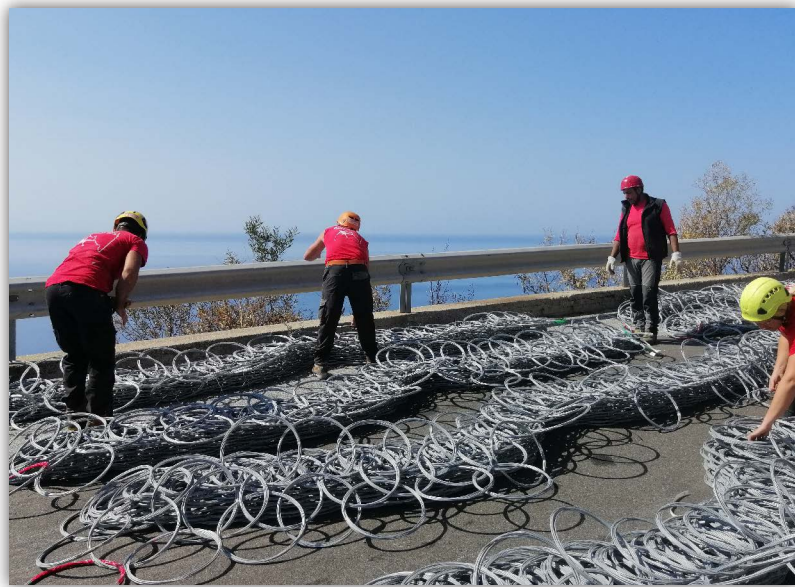
Barriere paramassi, fermaneve e simili SP23
