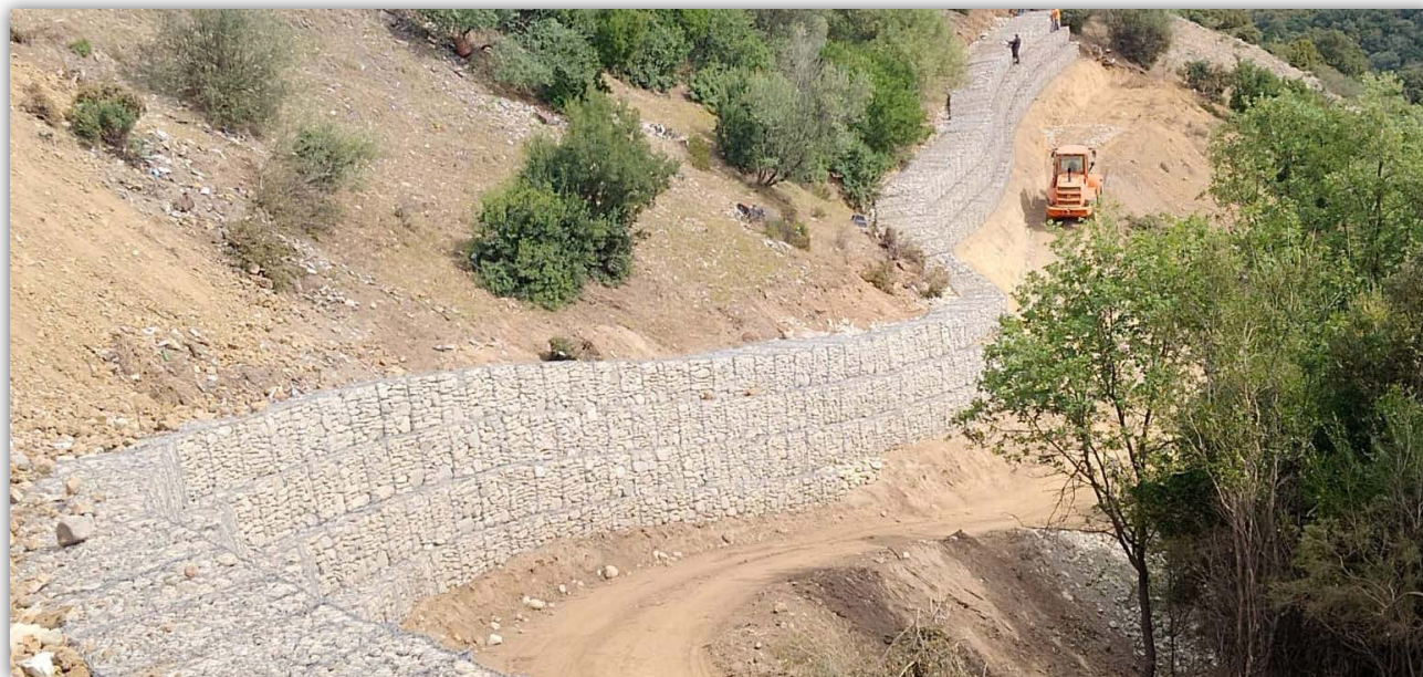
Opere e impianti di bonifica e protezione ambientale Realizzazione discariche ANAS Viabilità - Comune di Umbriatico (KR)
