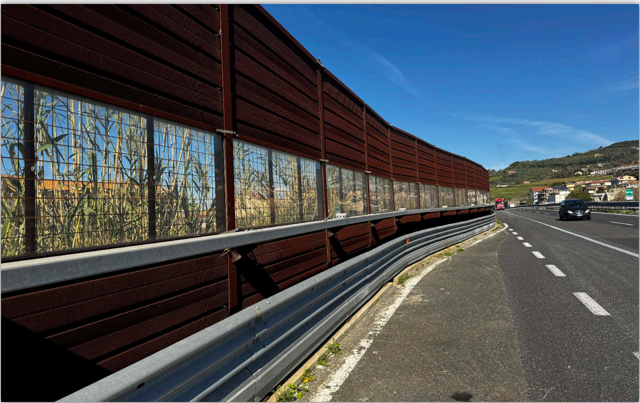
Installazione barriere antirumore Falerna (CZ) ANAS SPA - Autostrada A2 del Mediterraneo - dal km 308+800 al km 309+900 sede Sud
