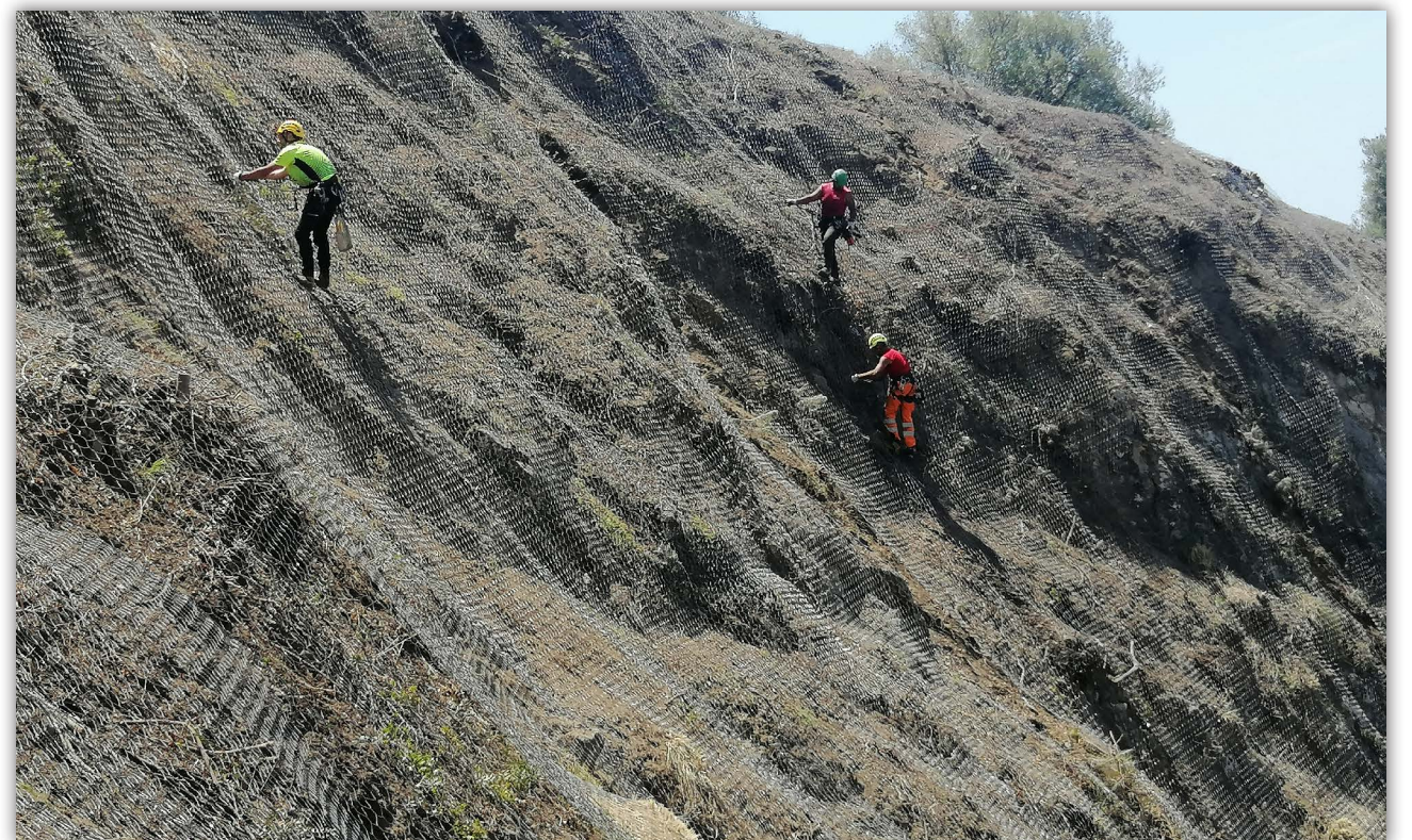
Barriere paramassi, fermaneve e simili ANAS Viabilità - SS18 Tirreno inferiore
